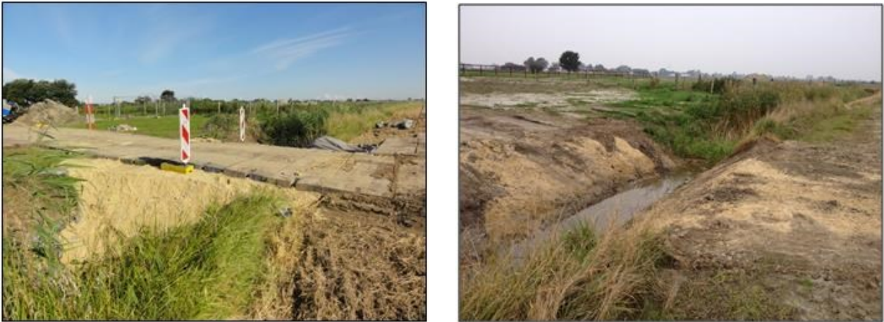
Abbildung 3: Beispiel einer temporären Grabenverrohrung (links) mit Rückbau (rechts)
