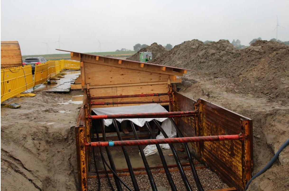
Abbildung 17: Bild eines Muffenverbau
