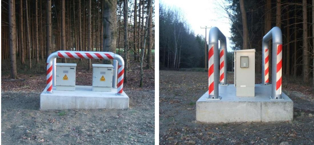
Abbildung 19: Crossbonding-Bauwerk mit Sicherheitsbügeln
