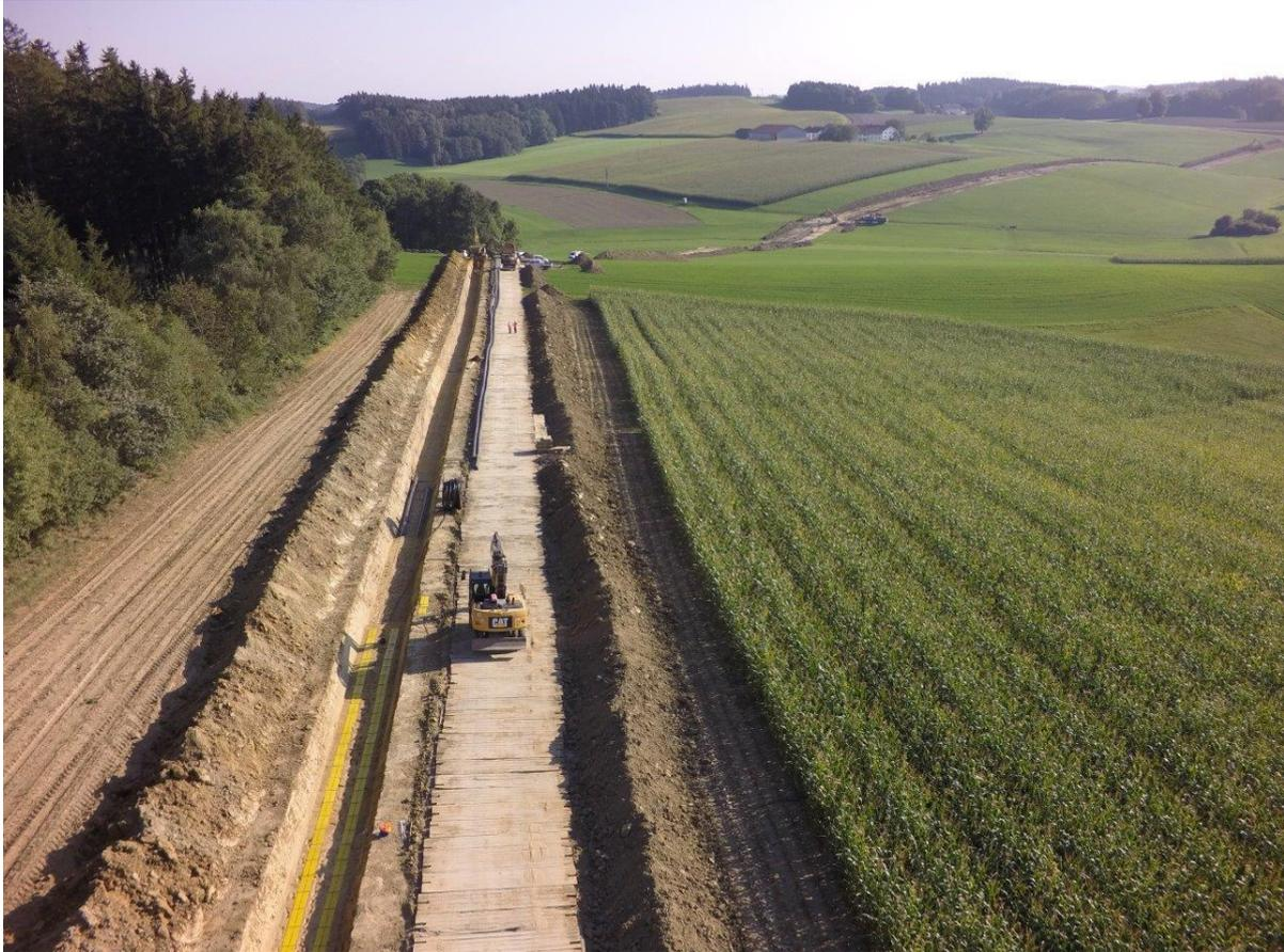
Abbildung 9: 110-kV-Kabelbaustelle der Bayernwerk Netz GmbH in Hörbering
