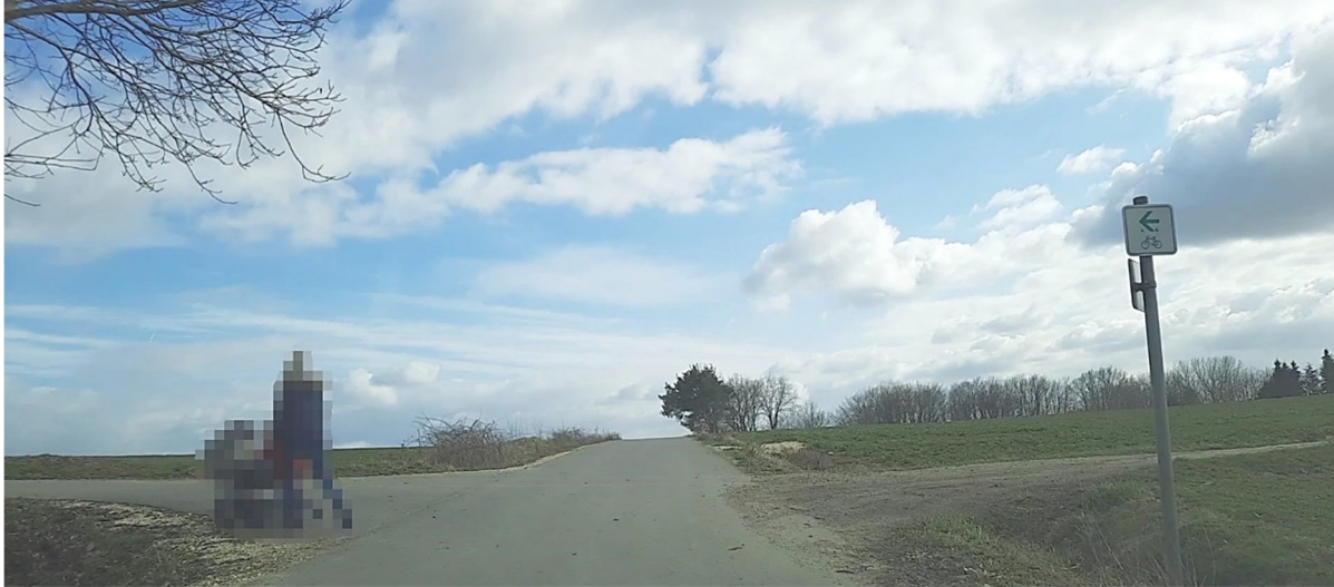
Bild 1: Standort bei Bau-km 0+000 mit südlicher Blickrichtung auf Kreuzung Kapellenweg und ländlicher Weg
