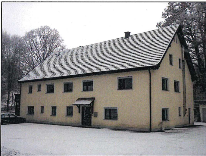
Abbildung 10: Wohnhaus "Talstraße 1" (hier: IO 6)
