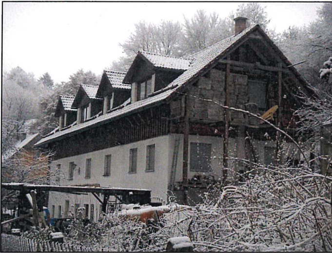
Abbildung 9: Wohnhaus "Kelheimer Straße 70" (hier: IO 5)
