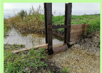
Eines von zwei Stauwehren zur Anhebung der Wasserstände (Foto: A. Hoyer / Reg. v. Ndb.).
